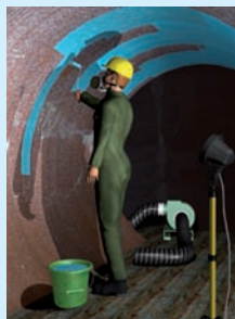
Absaugung von Löse- mitteldämpfen
